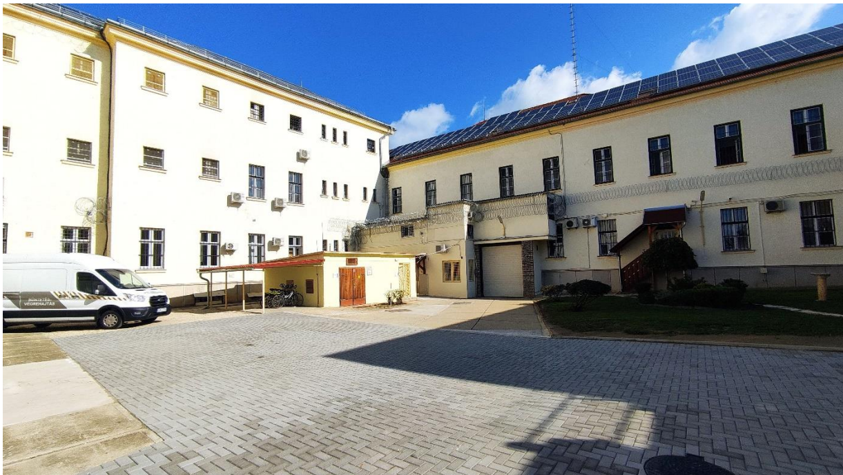
A bv. intézet felújított díszkőburkolatú udvara
