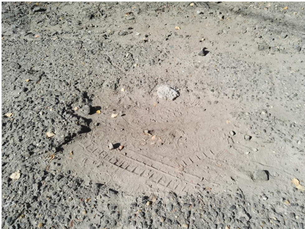
6. kép: Az udvar aszfaltburkolata
