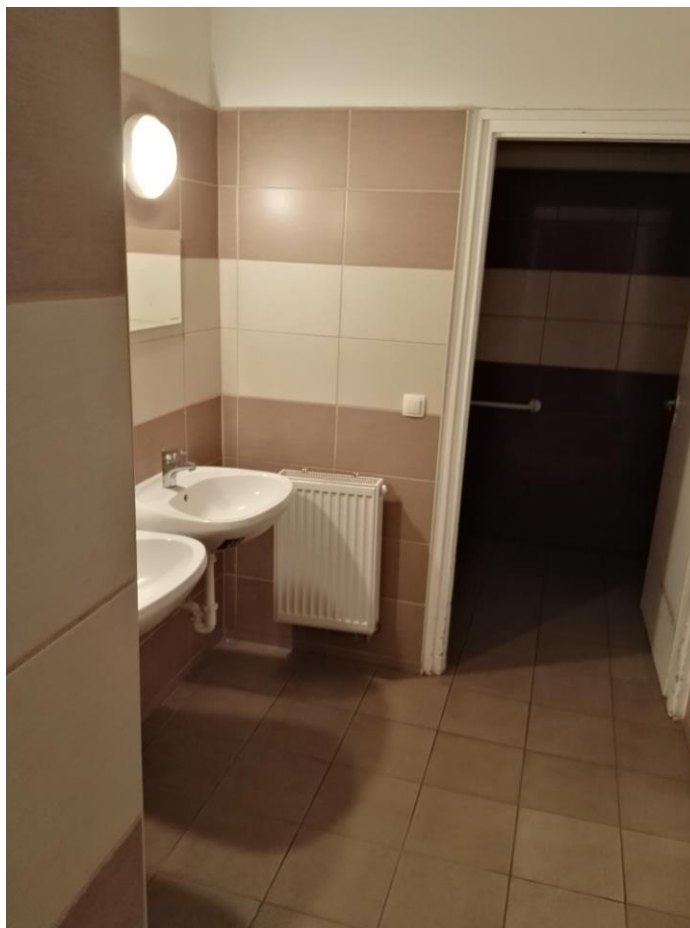
3. kép: Felújított illemhely
