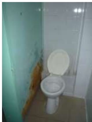
5-6. Debrecen, vizesedés nyomai a vizesblokkokban
