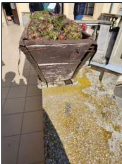
Balesetveszélyes, rögzítés nélküli, rozsdás virágládák a korláton
