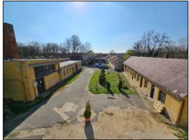
Balra a kazánház, jobbra a raktárból kialakított lakrész és a zöldségraktár, középen hátul az irodaépülete
