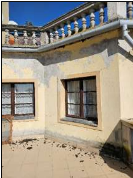
Kátrányos javítás és faljavítás nyomai
